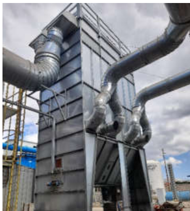
Figura 1: filtro a maniche a monte dell'emissione E14
